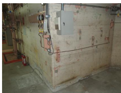
循環ポンプおよびろ過機撤去後
