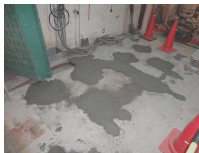
ろ過タンク撤去後
